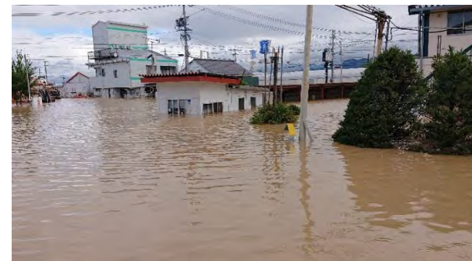
長野市内被害の様子
