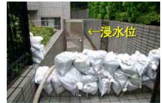
土のうを設置した事例
