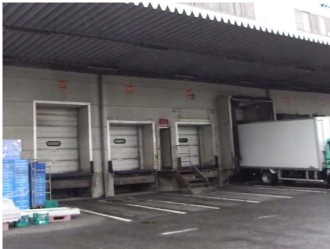
建物1階高さが高いため、床上浸水しにくい事例
